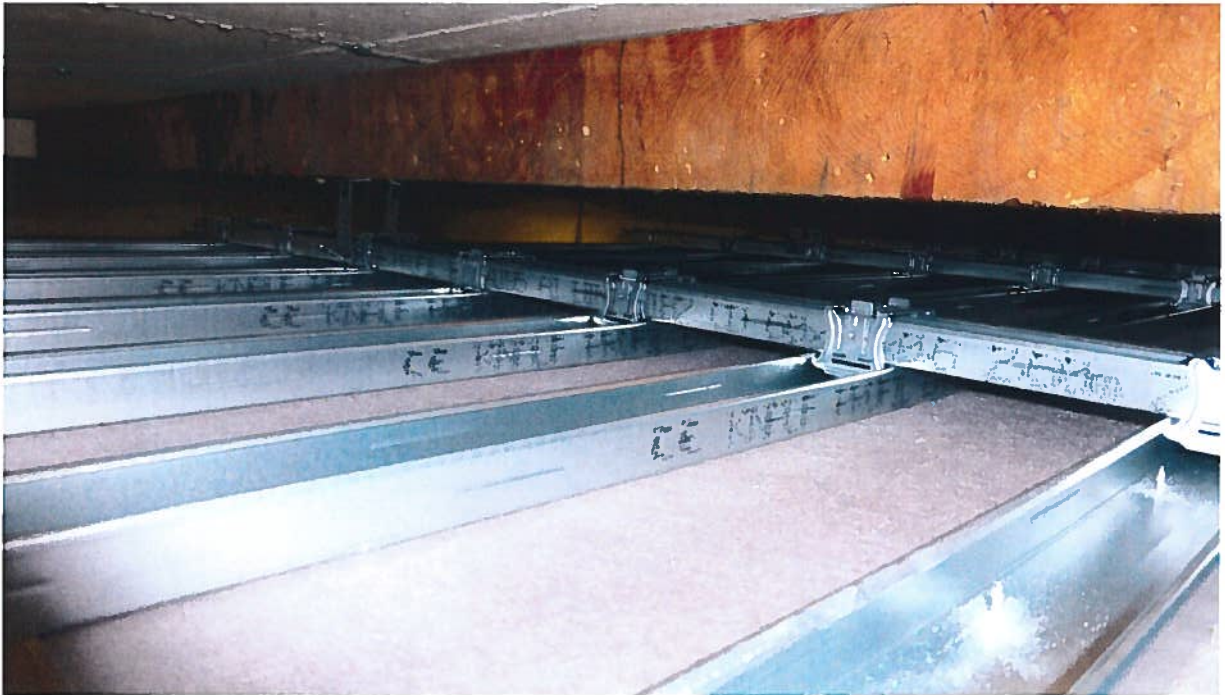
Bild 2 Detailansicht: Unterkonstruktion „D127 Knauf Cleaneo Akustik-Plattendecke Contrapanel“
